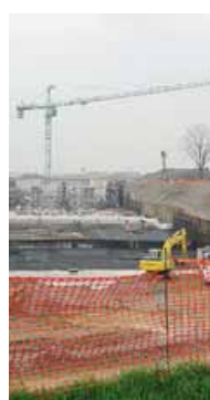
Cantiere Brebemi nella Bassa
